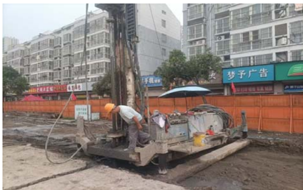
图3 钢板桩拔除跟踪注浆
