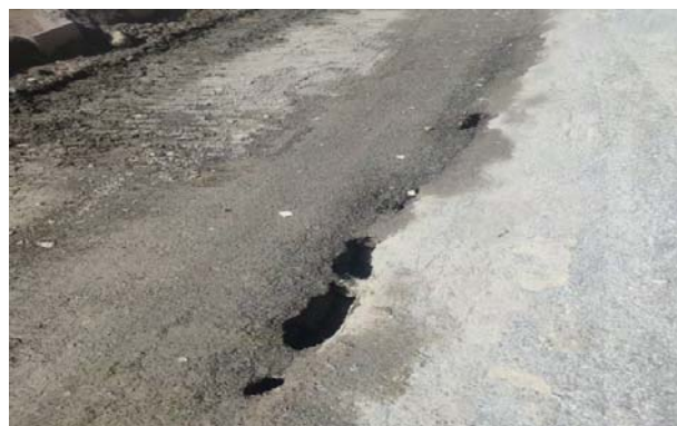
图1 钢板桩打设造成基槽周边地面裂缝
