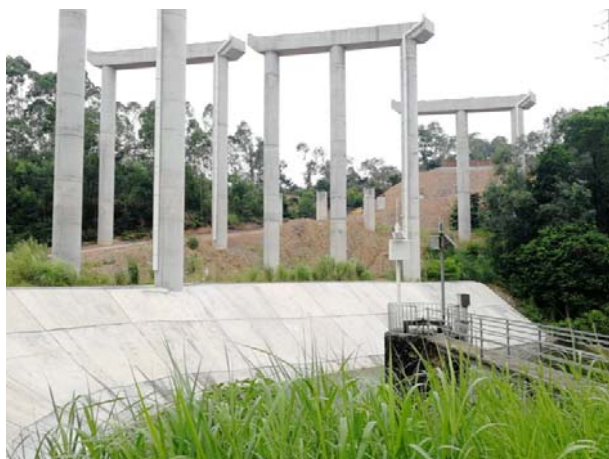
图1 涉水利工程构筑物卫星图及现场照片
