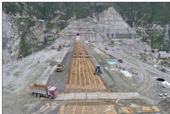
图1 水电站大坝枢纽工程施工现场
