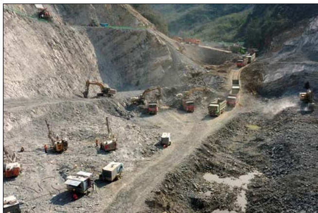
图2 施工现场边坡开挖
