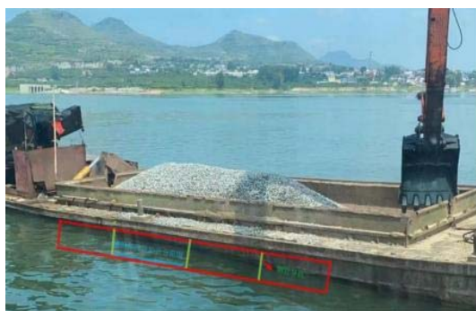
图3 抛砂卵石碎石基床细平
