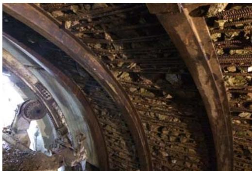
图1 桩号0+699断层破碎带
