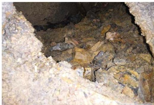
图2 断层破碎带拱顶上方塌方
