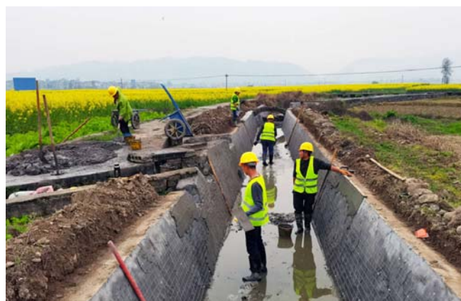
图一 水渠加固
