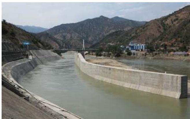
图1 混凝土围堰
