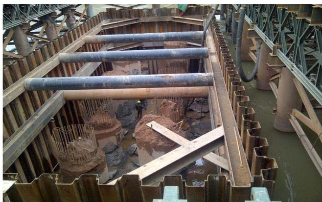
图2 钢板桩围堰
