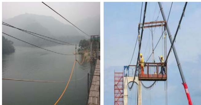
图3.5 主缆牵引 图3.6 临时挂篮施工
