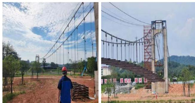
图3.8 吊杆及加劲梁安装
