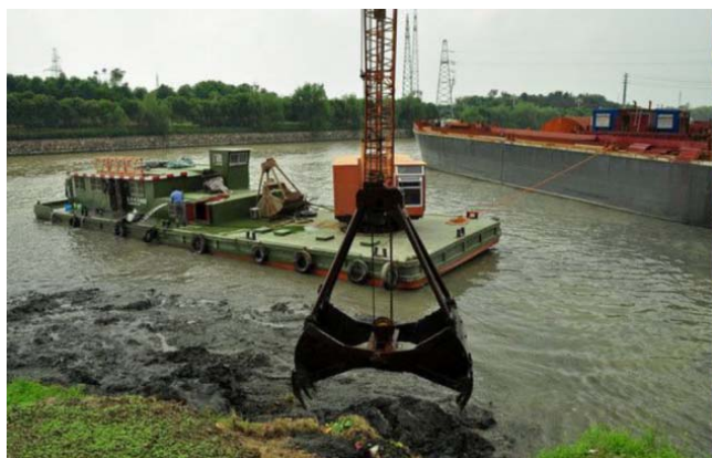
图1 利用相关水利工程对河道进行清淤
