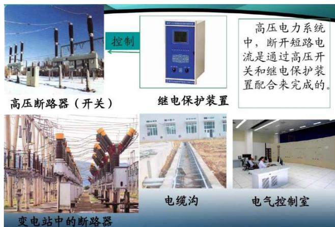
图2 电力系统中的继电保护实例
