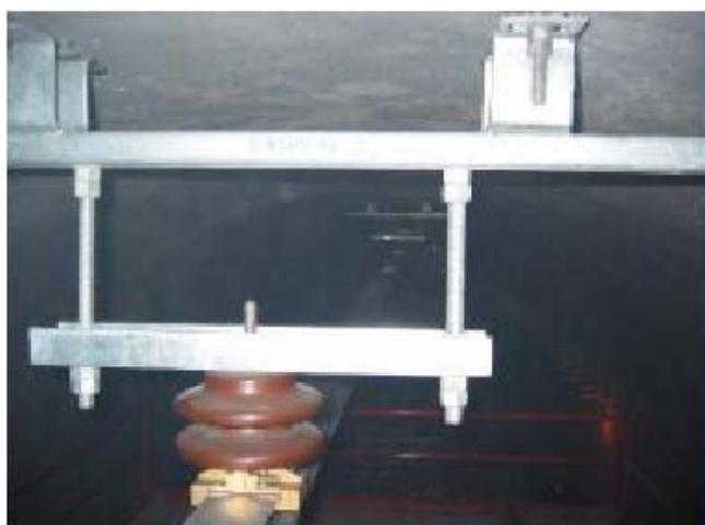
图2 刚性接触网垂直悬挂示意图
