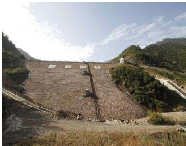
图2 石硐水库大坝
