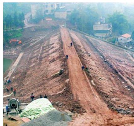
图1 大坝护坡施工
