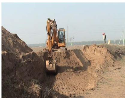
图1 明渠导流施工
