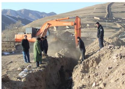
图1 沟渠挖掘图
