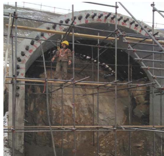
图1 导向墙施工面貌图
