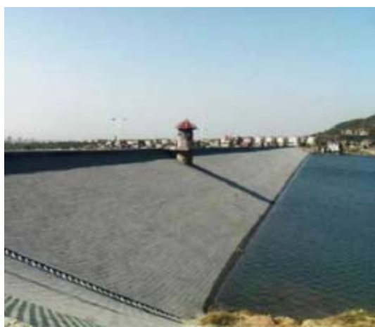
图1 水利工程项目
