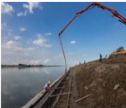
图2 水利工程施工
