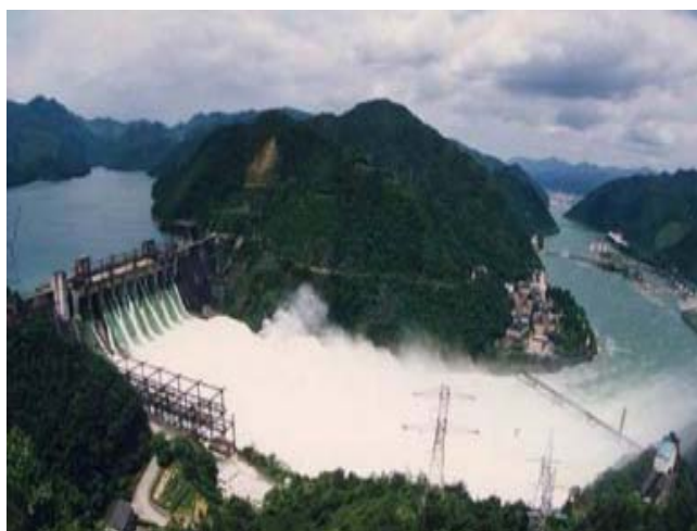
图二 水利水电工程施工
