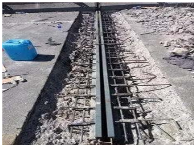
图2 伸缩缝处理
