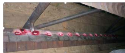
图三 补燃管道焊缝渗透试验
