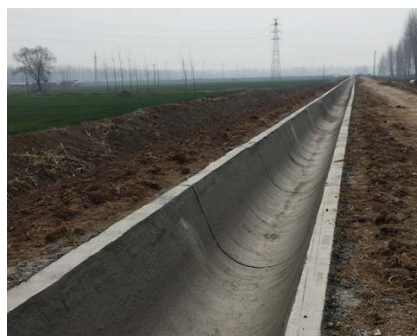
图1 水利渠道U型槽
