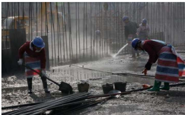
图1 水利水电工程的基础灌浆
