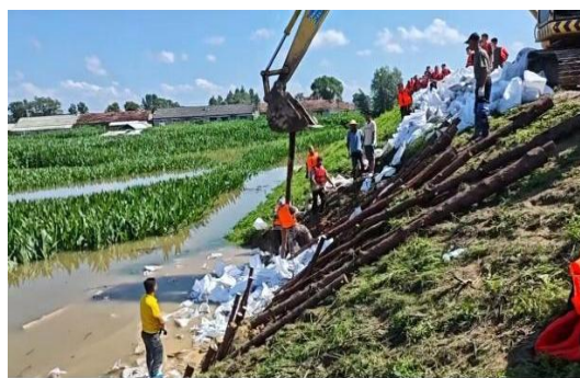
图3 挖掘机打桩固脚作业
