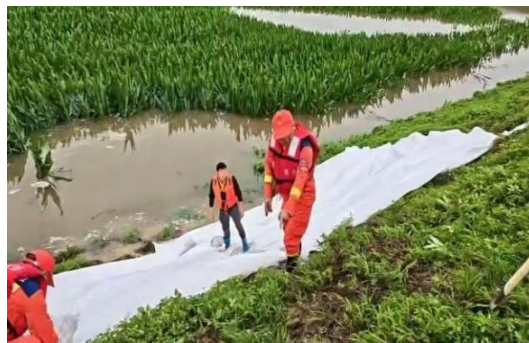
图2 核查反滤铺设质量
