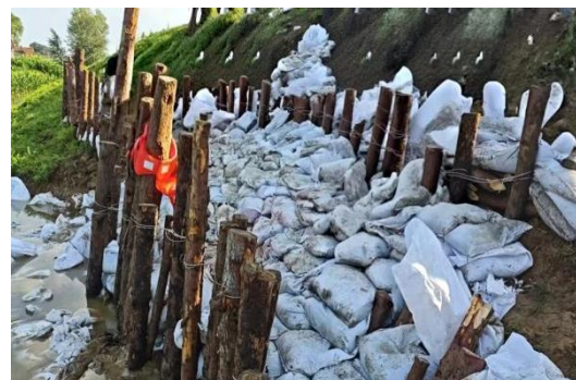
图4 加固处置完成后堤防现场
