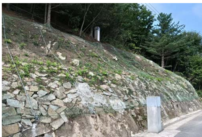
图1 铁甲水库山体护坡
