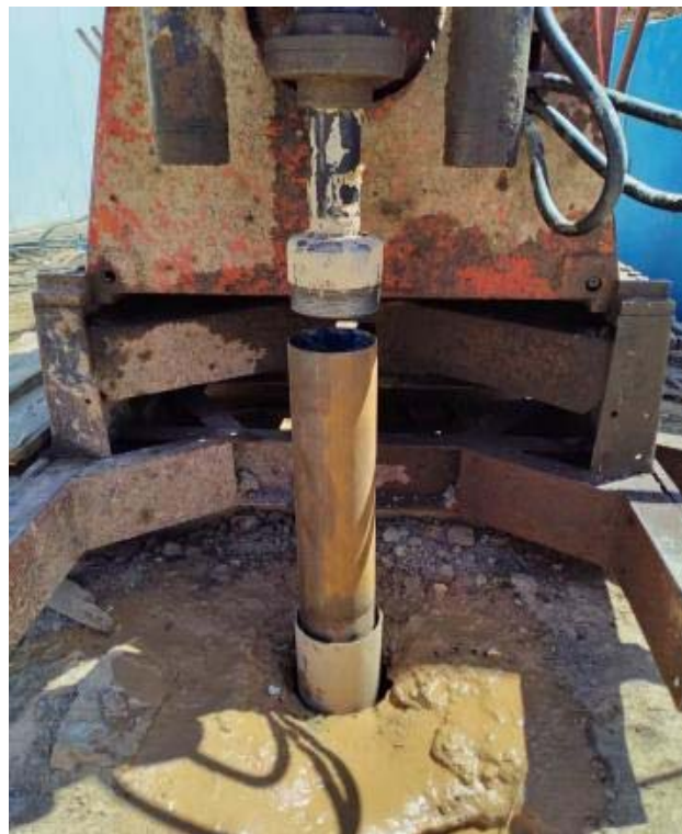
图1 套管跟进钻孔施工现场示意图
