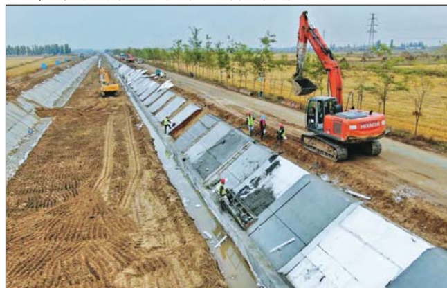
图1 A县节水灌溉工程施工现场
