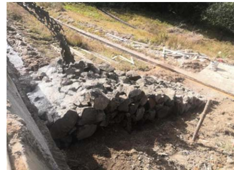
图1 龙陵县杨梅坡水库除险加固前
