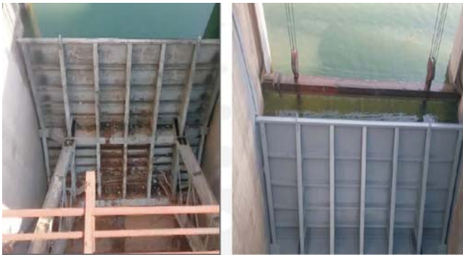
图2 双牌水电站进水弧门采用冷喷锌防腐修复
