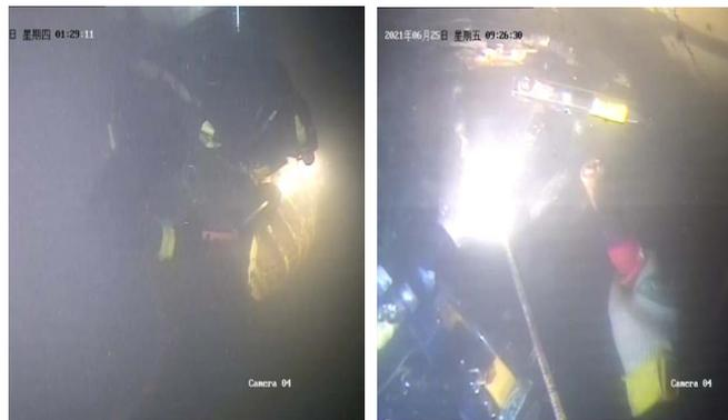
图2 1号放空底孔充水管进口拦污栅水下切割
