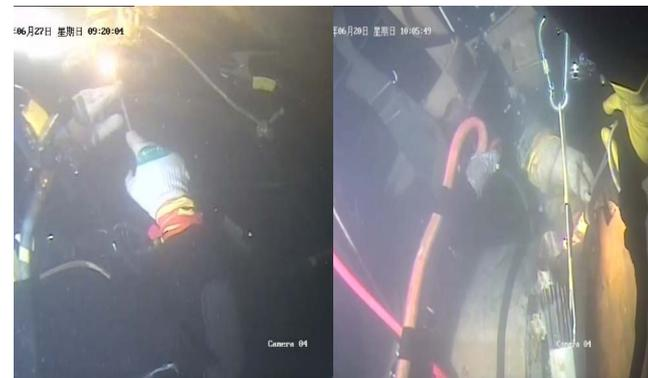
图3 1号放空底孔充水管取水口封板水下焊接
