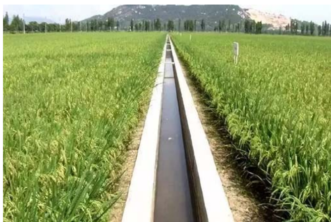
图1 农田灌溉水利工程
