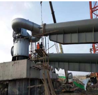
图2. 3-4 连接管安装
