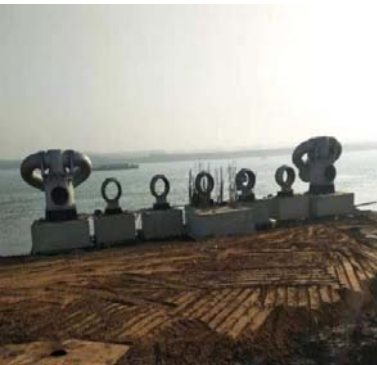
图2. 3-3 岸上接头安装
